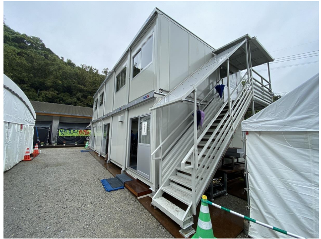
運営本部や記録本部等の諸室を確保するために設置されるプレハブ。写真のライフル競技会場のように2階建てのものもある。（鹿児島市）
